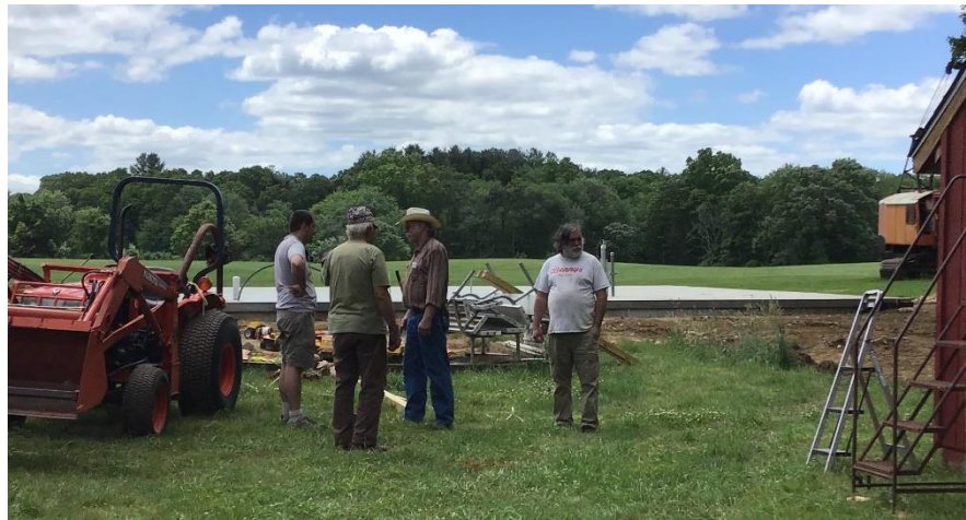
The post hole digging crew (Karl, Dave B., Craig, & Charlie)
